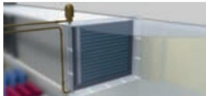
Mit dem Anschlussmodul können externe Wärmetauscher direkt an das KX6-Kältemittelsystem ange- bunden werden – wie zum Beispiel eine vorhandene Lüftungsanlage.
